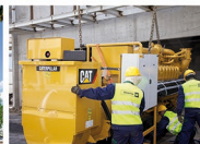
CIEPŁOWNIA MIEJSKA W KUTNIE
